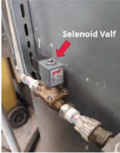
SET Montaj Alanı Hava Girişi
